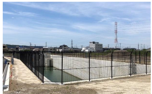
熊野桜佐雨水3号調整池
